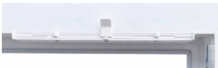
/ Von dem neuen FFLM-Lüfter ist in eingebautem Zustand bei geschlossenem Fenster lediglich der kleine Schieberegler zu sehen.
