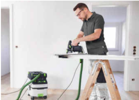
/ Auch dickere Brand-, Rauch- oder Schallschutztüren bis 60 mm lassen sich mit einem Schnitt kürzen.
