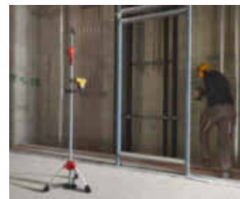
/ Das Baustativ STE-BS wiegt 1,5 kg und dient als Zubehör für Deckenstützen.
